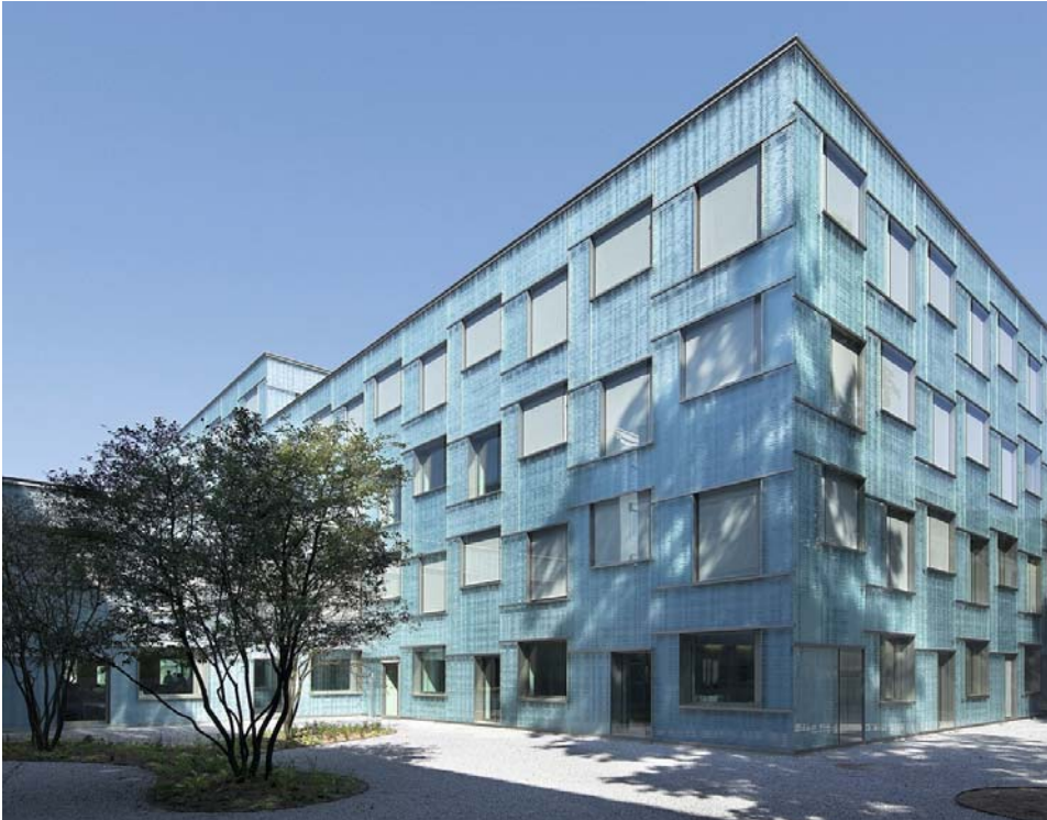
Teil der Betriebsoptimierung: ein Axpo-Verwaltungsgebäude in Baden.
